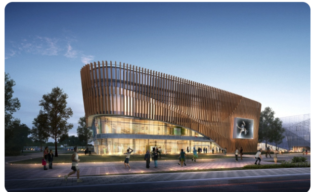
工程项目：王楠国球馆 工程地址：山东省/威海市 设计面积：8200m 2
