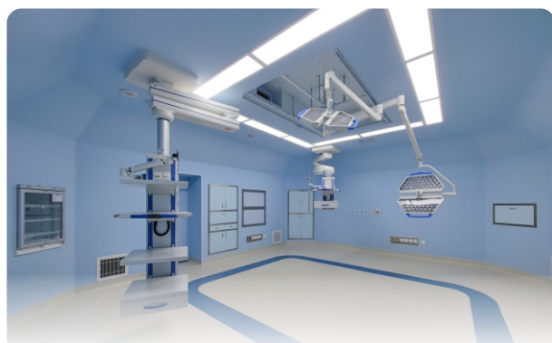
工程项目：佛山南海区人民医院 工程地址：广东省/佛山市 洁净等级：百级
