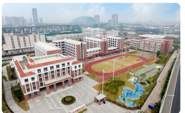
工程项目: 桂城街道文翰二小 工程地址: 广东省/佛山市 建筑面积: 36472m 2
