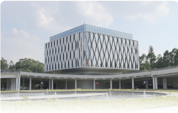
工程项目: 佛山南海生活垃圾焚烧发电厂 工程地址: 广东省/佛山市 安装规模: 1600冷吨
