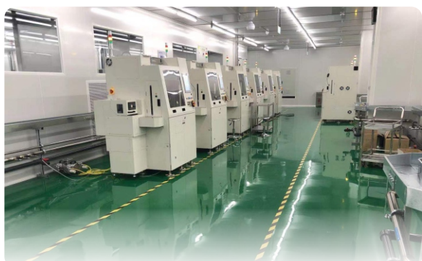
工程项目：纳米智能技术科技园三期 工程地址：广东省/广州市 洁净等级：百级
