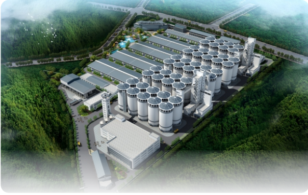
工程项目: 佛山粮油储备库一期 工程地址: 广东省/佛山市 建筑面积: 154467.53m 2
