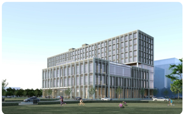
工程项目: 东莞市盛雄激光智能装备总部 工程地址: 广东省/东莞市 建筑面积: 36732m 2
