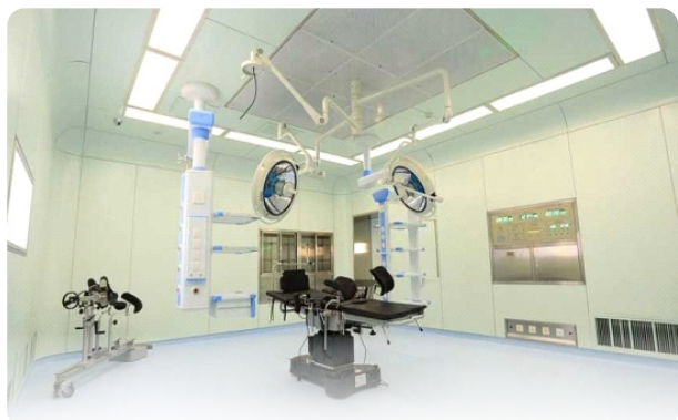
工程项目：韶关新丰县人民医院综合楼及住院楼 工程地址：广东省/韶关市 洁净等级：百级
